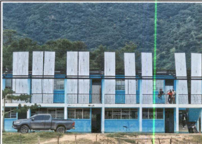
Foto1: MEJORAMIENTO DE TECHO A LAMINA TROQUELADA CALIBRE 26 Y MANTENIMIENTO DE ESTRUCTURA PORTANTE GENERAL
